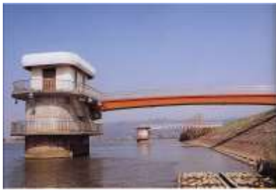
鹿又取水場 1 号取水塔（旧北上川）
