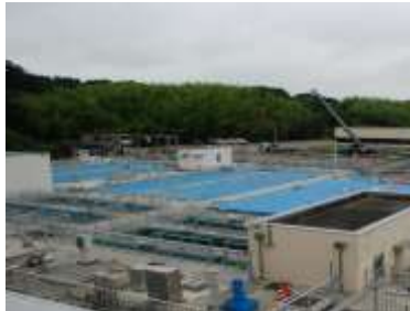
須江山浄水場
