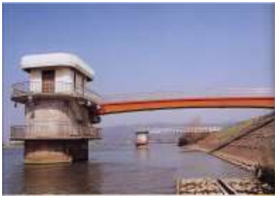
鹿又取水場 1 号取水塔（旧北上川）
