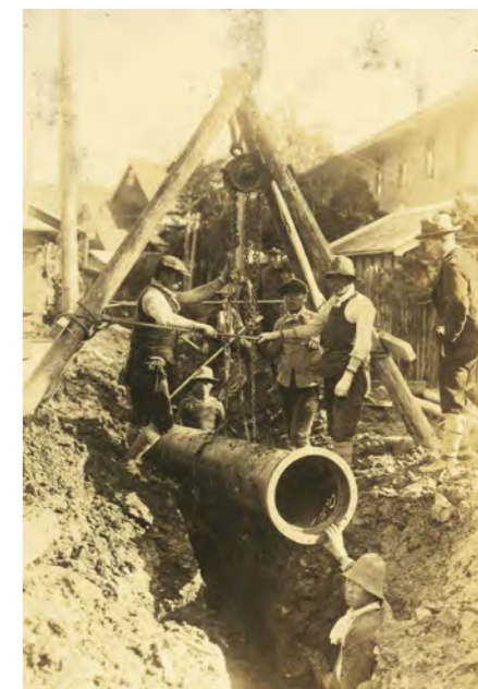
導水管布設工事（1931年）
