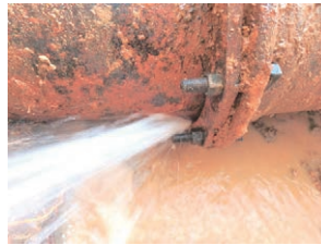
老朽化した水道管と浄水施設の写真
