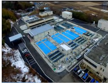
須江山浄水場
