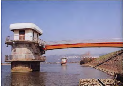
鹿又取水場 1 号取水塔（旧北上川）
