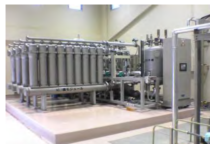
雄勝地区原浄水場
