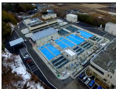
須江山浄水場
