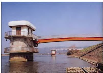
鹿又取水場 1号取水塔 (旧北上川)
