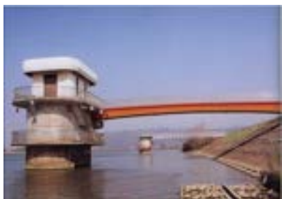
鹿又取水場 1 号取水塔（旧北上川）
