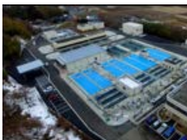
須江山浄水場
