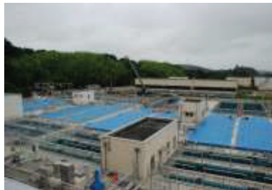
須江山浄水場
