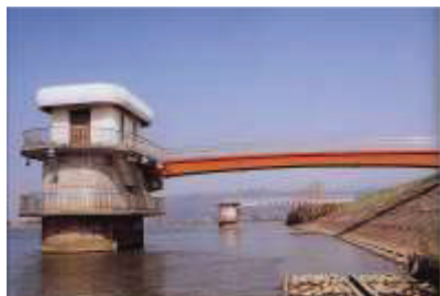
鹿又取水場 1 号取水塔（旧北上川）
