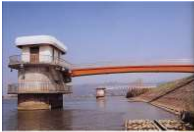
鹿又取水場 1号取水塔（旧北上川）
