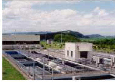
須江山浄水場
