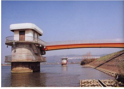
鹿又取水場 1 号取水塔（旧北上川）
