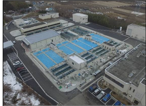
須江山浄水場
