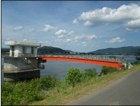
鹿又取水場 1号取水塔
