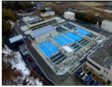
須江山浄水場
