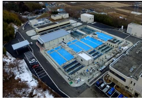
須江山浄水場
